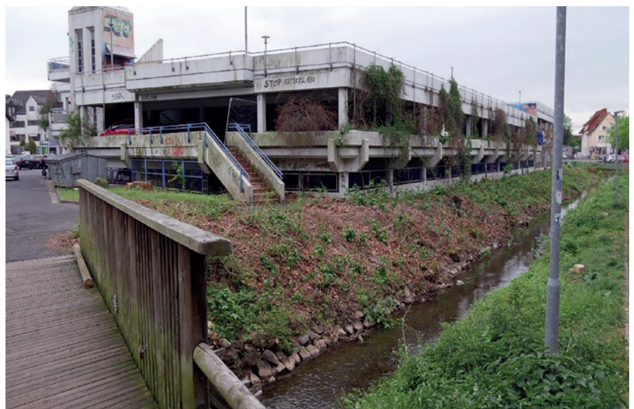
Blick auf das Parkdeck aus den siebziger Jahren
